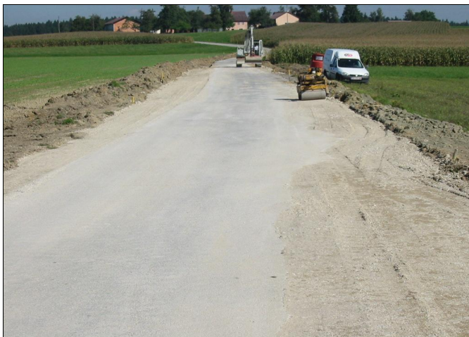
Ausbautrecke Richtung Kiesenberg
