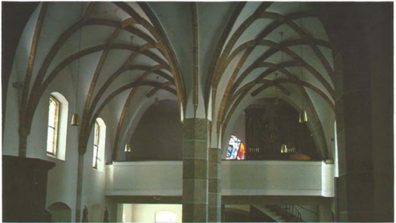
Gotisches Kreuzrippengewölbe
