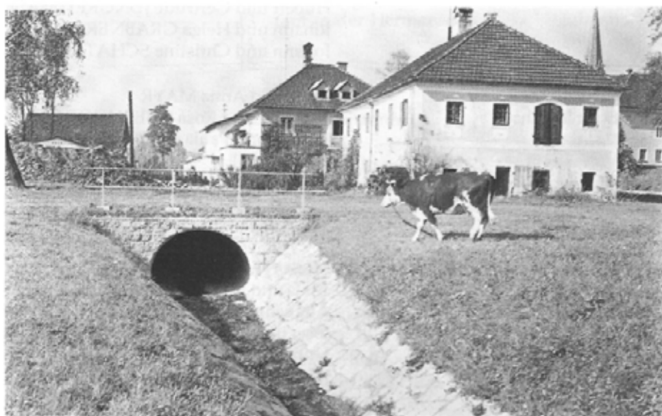
Mündung des Minithalbaches in den verrohrten Abschnitt. Das Schörgenhummerhaus wurde mittlerweile abgetragen
